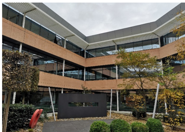
Façade du Suravenir, à Brest, avec les casquettes composées de lames brise-soleil
