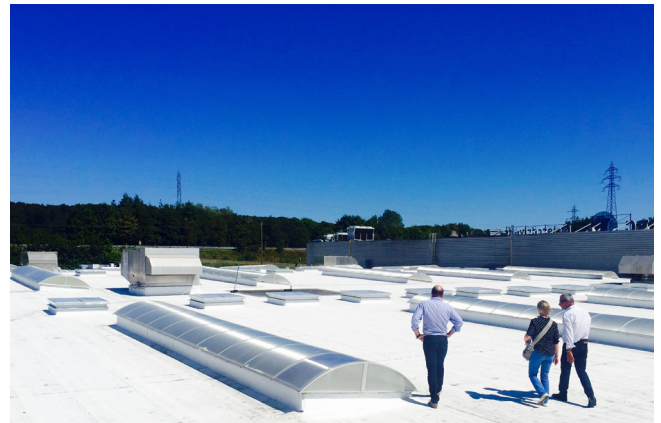
Toiture du Leclerc de Quimper
