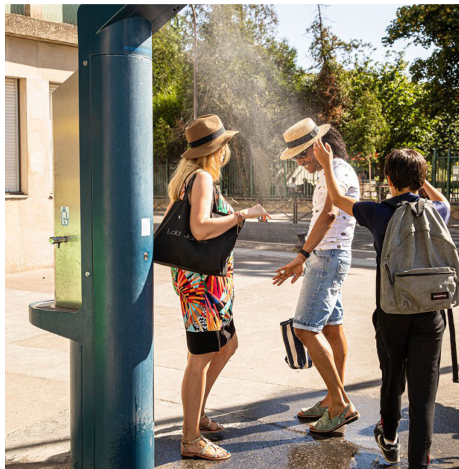
Dispositif double usage de brumisation et de boisson Source : Eau de Paris
