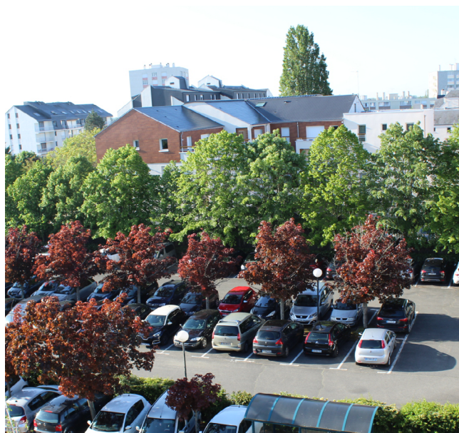
Parking de la Caf du Loiret situé au-dessus des sondes géothermiques verticales
