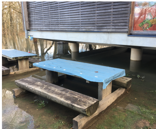
Pilots supportant le bâtiment en période de crue
