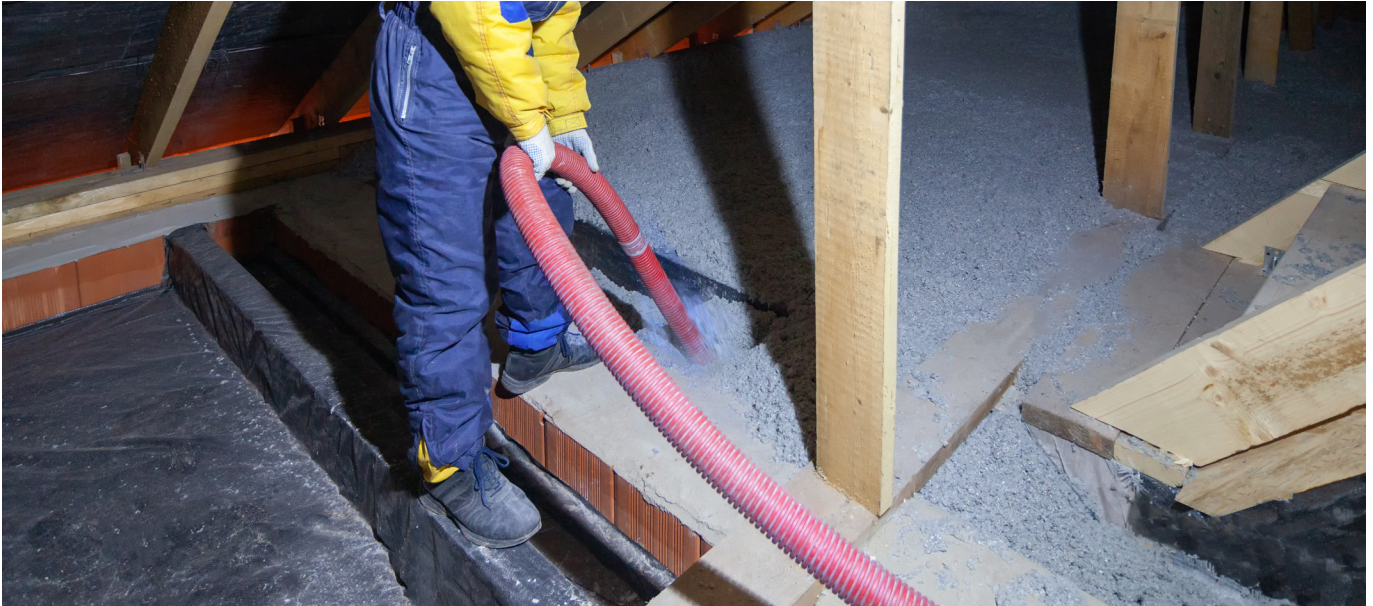
Isolation des combles avec de la ouate de cellulose
